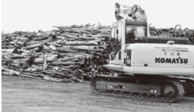
ボイラー燃料を作る下川町の木質原料施設。発電には大量の原料が必要になる
