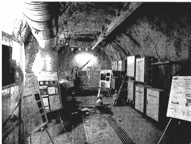
“核のゴミ”の地層処分に向けた試験が続く幌延の施設。最深部の地下水湧出量は数百トン/日。試験研究の適地もない（撮影：天笠啓祐）
