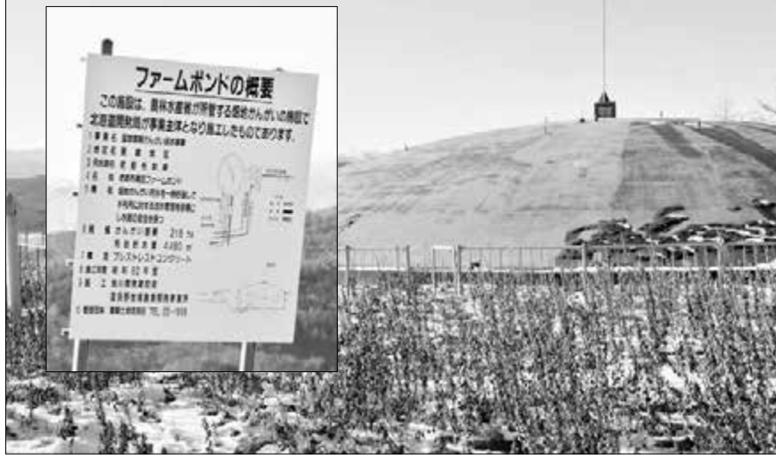
高台でいったん、かんがい用水を貯める「ファームポンド」。合計14カ所に建設された
