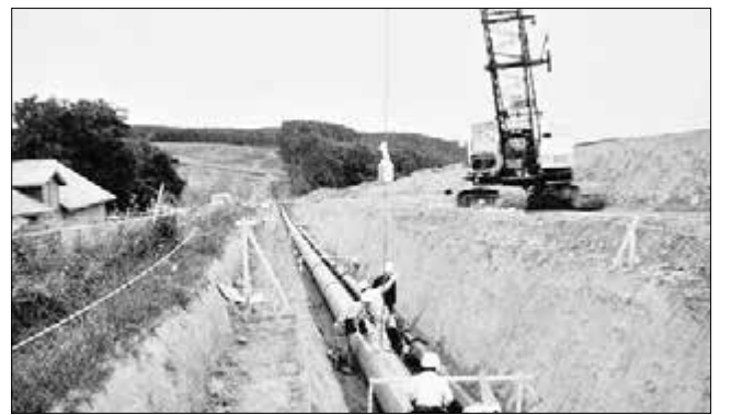
1980年前後に施工中の幹線かんがい用水路（東郷土地改良区『改組20年誌』から）
