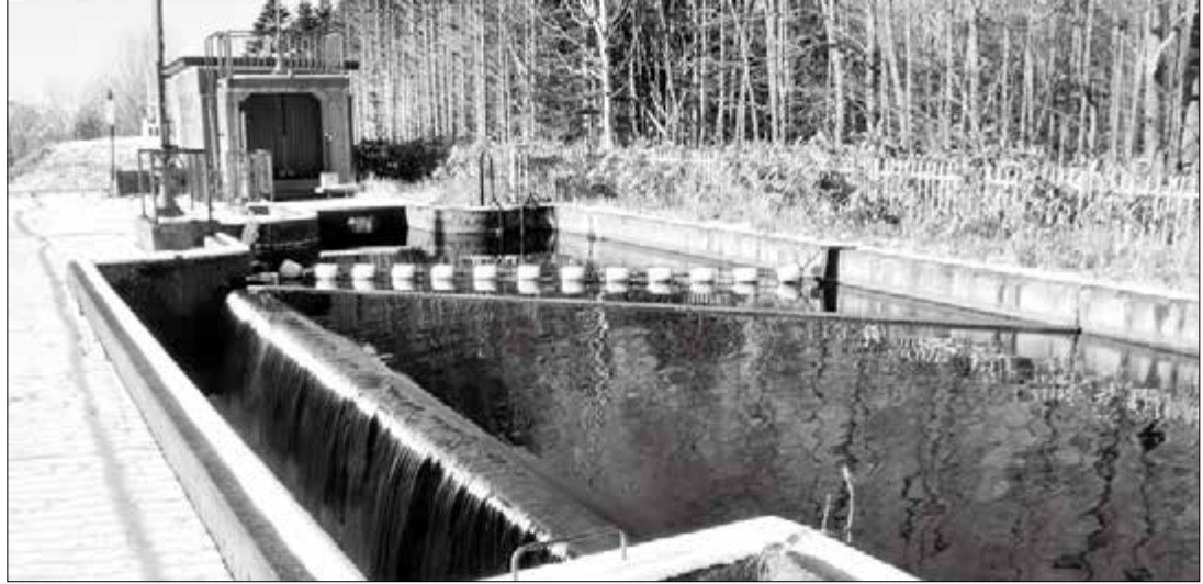
1970年代半ば、東郷ダムに先駆けて完成した「ボンヌノッペ頭首工」に隣接するかんがい施設。この水は麓郷とその北側の地域に供給中
