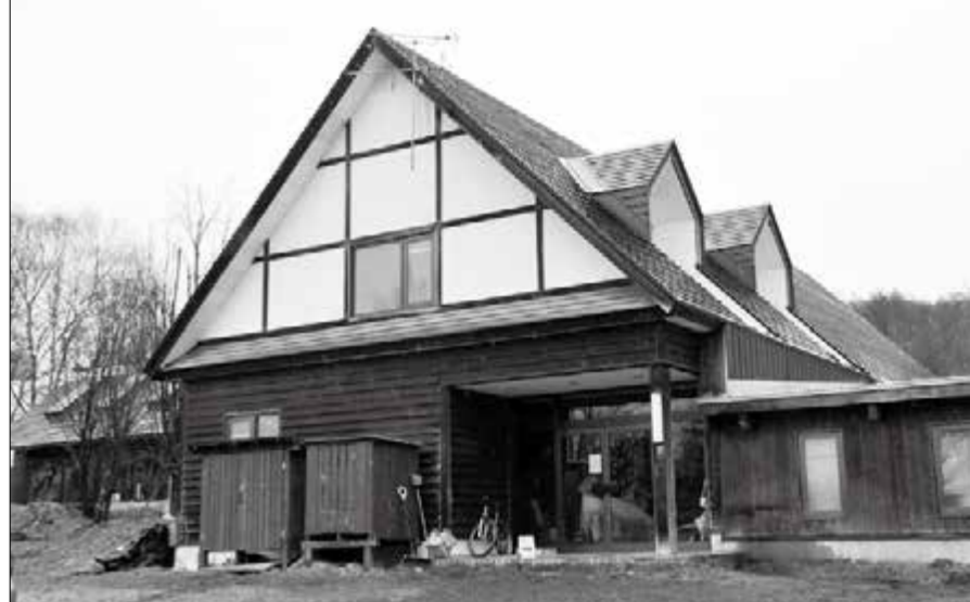
1991年に建設した共働学舎のチーズ工場。牛舎と工場を接近させ、自然流下によって生乳が送られるように設計されている
