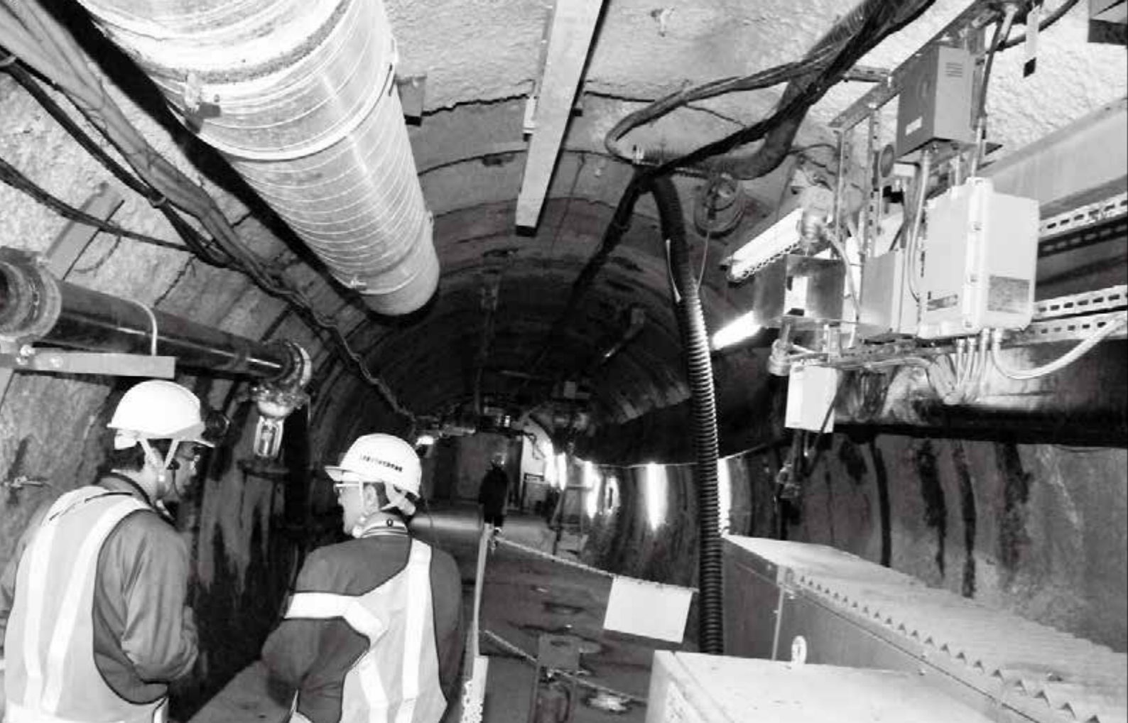
幌延深地層研究センターでは、地下140m地点に設置した調査坑道を使い、放射性廃棄物の地層処分に向けた各種試験が続く。地下水の湧出量は日量100～120t。「施設の周辺地域が最終処分場に狙われるのでは…」という声が強くなる(昨年11月撮影)
