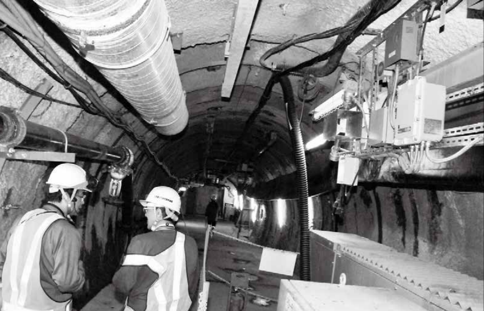
幌延深地層研究センターでは、地下140m地点に設置した調査坑道を使い、放射性廃棄物の地層処分に向けた各種試験が続く。地下水の湧出量は日量100～120t。「施設の周辺地域が最終処分場に狙われるのでは…」という声が根強くある(昨年11月撮影)
