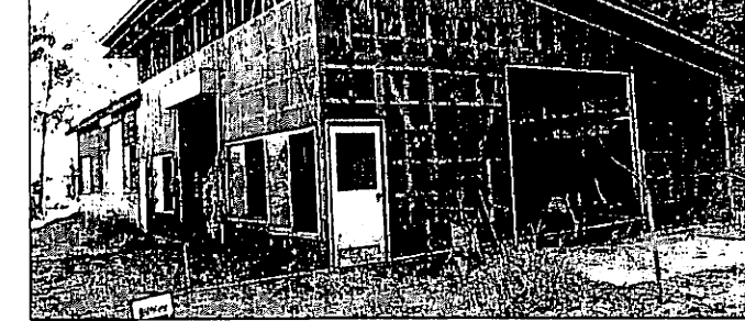
佐竹さんの手で建設した牛舎。採光に配慮し、室内は明るく清潔に保たれている
