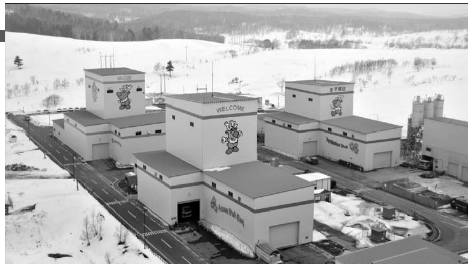
展望室から見た坑道の建屋。東西2本の立坑と換気立坑がある
