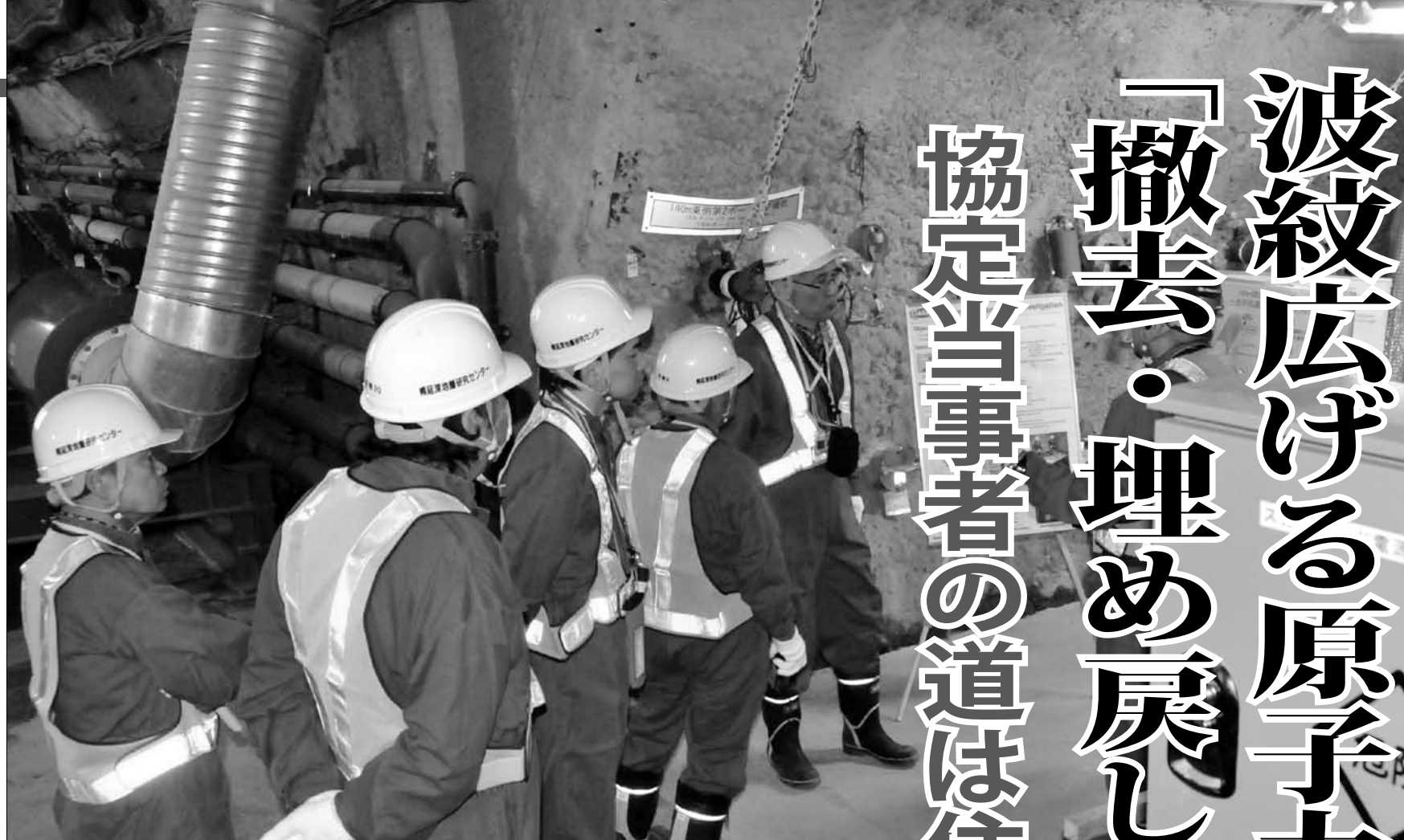
幌延深地層研究センターが掘削した地下140mの調査坑道では、地下水や岩盤の状態などを調べている。現在、立坑は380mまで掘られ、500m地点での研究計画もある(今年3月撮影)
