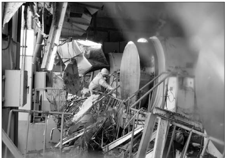
福島第1原発の使用済み核燃料乾式貯蔵施設は「3・11」大震災で津波に襲われたが、金属容器の中は無傷だった(東京電力のHPから)
