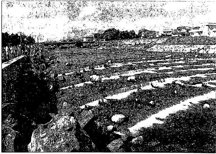
▲恵庭市内の漁川での多自然型工法の事例。よそから運んだ自然石を張りつけ、不自然な印象を受ける
