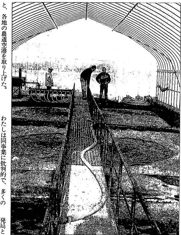
漁業団体が出資して浜中町内の酪農家に設置された微生物群を使った牛の糞尿処理施設
