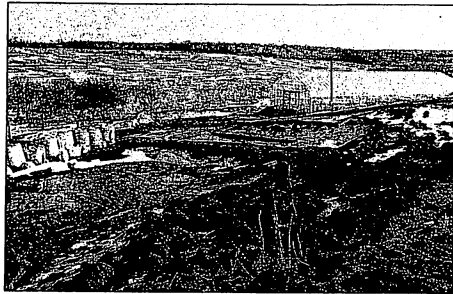
スラリー(糞尿)から上澄みを分離して、右手ハウス内の処理槽に導く。以前は川に流れ込んでいた
